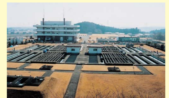
松田新田浄水場
